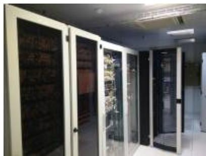
**Et la dernière salle, la salle 3 qui est toute neuve et est équipé d'un système de ventilation différents des deux autres salles, le confinement d'allée.**
